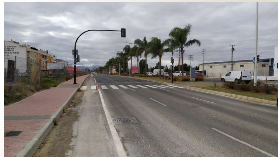
Av. Reino de Murcia (intersección con Juan de Borbón).
